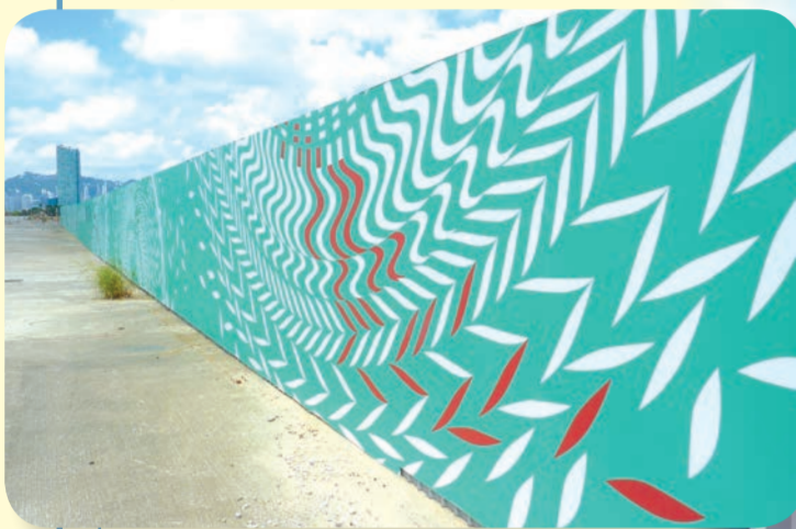
工地臨時圍板 Temporary site hoarding
